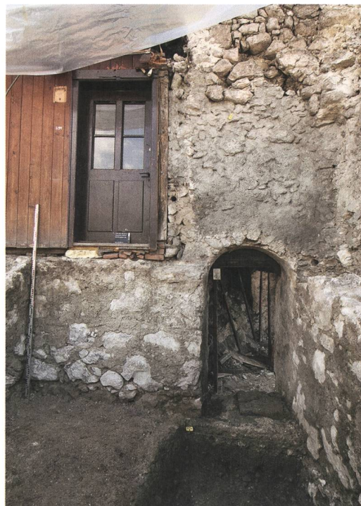
Abb. 14: Stocken-Höfen, Stockentalstrasse 33. Das Erdgeschoss des Glockenturms der Kapelle mit dem wieder geöffneten Zugang in der nördlichen Chormauer und darüber der Haustüre des späteren Wohngebäudes nach der Freilegung im April 2018. Blick nach Süden.
