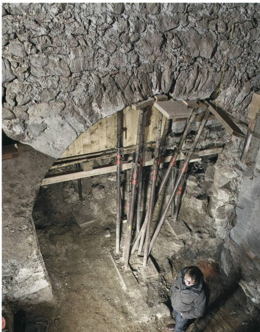
Abb. 5: Stocken-Höfen, Stockentalstrasse 33. Der Chorbogen und der bereits teilweise freigelegte Chor der Kapelle im März 2016. Blick nach Südosten.
