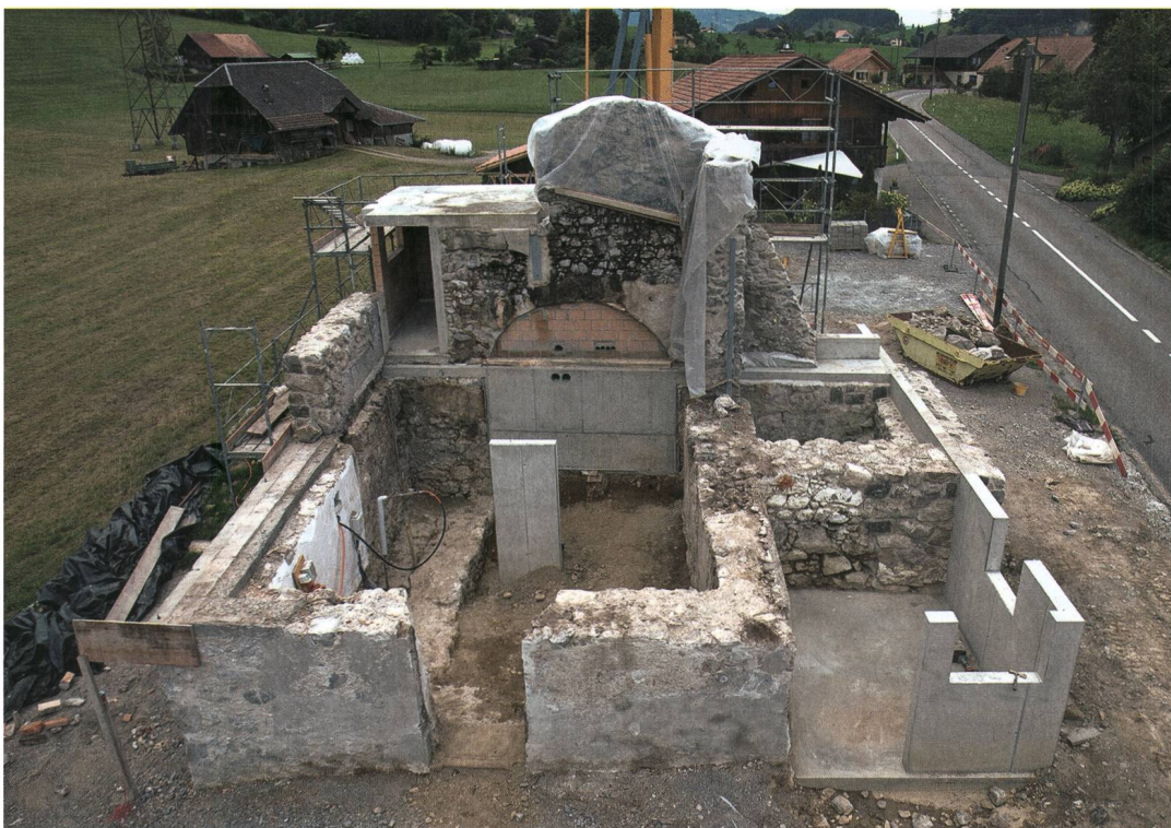
Abb. 10: Stocken-Höfen, Stockentalstrasse 33. Drohnenfoto des Gebäudes nach Abbruch aller jüngeren Mauern und den Vorbereitungsarbeiten für das neue Holzhaus im Juli 2018. Vorne im Bild der Chor mit dem verbreiterten Ostfenster, dahinter der bereits neu zugemauerte Chorbogen und rechts der Turmsockel. Blick nach Nordwesten.
