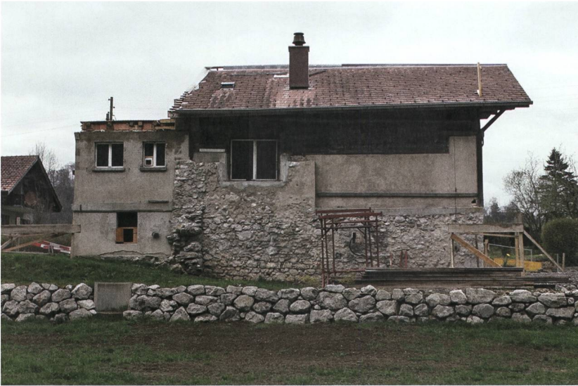
Abb. 8: Stocken-Höfen, Stockentalstrasse 33. Das Wohnhaus im April 2018 nach dem Abbruch von Teilen der Ökonomiebauten. Klar zu erkennen ist das Natursteinmauerwerk der Südseite des Kapellenchors mit dem Ansatz der südlichen Chorschulter. Blick nach Nordosten.
