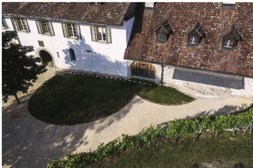
Abb. 4: Twann-Tüscherz, St. Petersinsel. Die Fläche der Haupt- und der nördlichen Seitenapsis der älteren Basilika I wurde mit Rasen begrünt und mit Metallbändern umfasst. Blick nach Südwesten.
