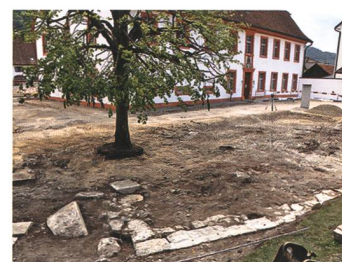
24 Courtelary, Rue de la Préfecture 2
