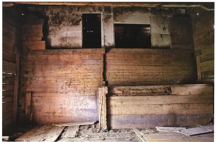
Abb. 7: Aeschi b. Spiez, Suldhaltenstrasse 31. Nordfassade des Wohnteils vom Heuboden aus gesehen. Die Blockkonstruktion der Nebenstube von 1779 springt in die Ökonomie vor. Darüber liegt die durchlaufende Blockwand zum Gaden des Ursprungsbaus von 1559. Hierauf ruhen wiederum die Enden der Blockvorstösse der 1849 neu angefügten grösseren Ökonomie.
