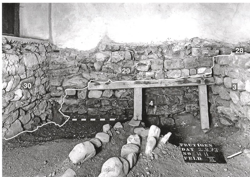
Abb. 14: Frutigen, Kirche. Ansicht an die nördliche Schultermauer des Schiffes (Tagebuchs-kizze und Foto). Unter der vorkragenden Schultermauer von 1727 (29) liegt das ältere gerade Mauerstück (4). Blick nach Osten. M. ca. 1:50.
