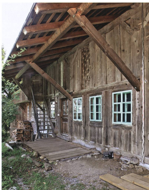
Abb. 10: Rüschegg Sangern 183. Wohntrakt der nördlichen Haushälfte zwischen dem zweiten und vierten Querbund. Die Nebenstube im Vordergrund (Raum 7, Abb. 13) ersetzte einen Schmalviehstall. An den Bundachsenschnittpunkten zeigen sich auf Schwellbalkenhöhe die alten Zapfenschlösser. Gerüst und Gefüge im Dachgeschoss sind überwiegend original. An den Ständerbohlenwänden finden sich die regionaltypischen, tupfenartigen Verzierungen. Blick nach Südosten.
