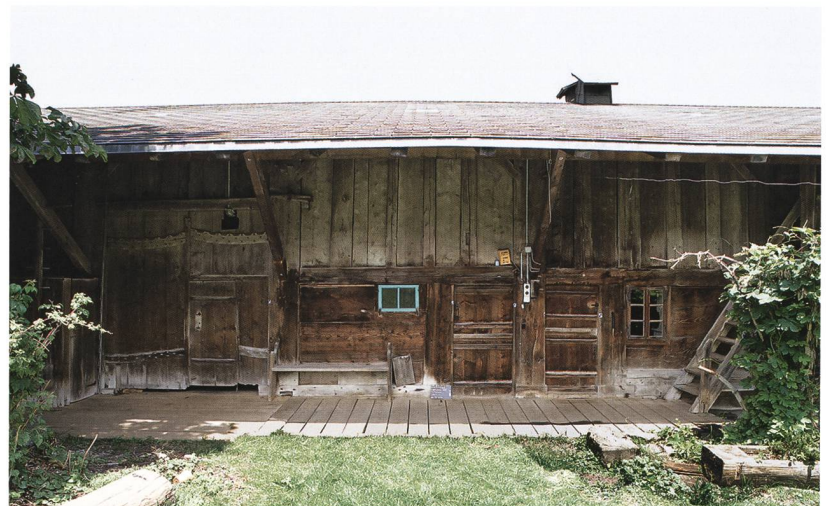
Abb. 16: Rüschegg Sangern 183. Südliche Haushälfte zwischen dem zweiten und fünften Querband. Abgesehen von den vergrösserten Fenstern präsentiert sich dieser Bereich in ursprünglicher Gestalt. Blick nach Norden.
