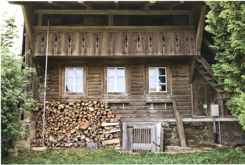
Abb. 24: Rüscheegg Sangern 183. Der Wohntrakt der nördlichen Haushälfte wurde 1880 mehr oder weniger komplett modernisiert. Bei der Stube (Raum 3) handelt es sich um eine neu abgezimmerte Konstruktion. Weil sich dabei auch die Raumhöhe vergrösserte, musste die alte Vordachlaube (48) angehoben werden.
