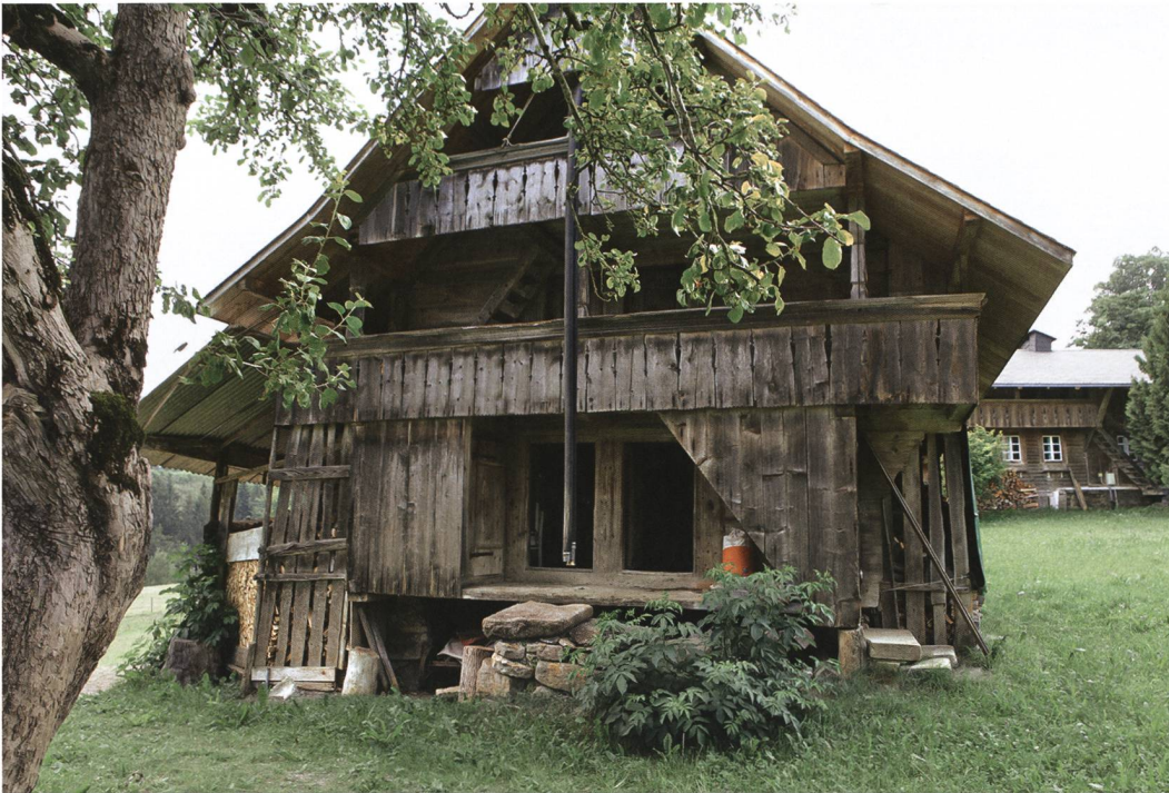
Abb. 19: Rüschegg Sangern 183. Blick nach Süden auf den zum Hostettlergut gehörenden Speicher Nr. 184. Auf dem als Türsturz dienenden Bundbalken ist eine in Fraktur eingekerbte Inschrift angebracht. Sie verkündet, dass «Peter-Hocheter [sic!] Im Jahr 1766» dieses Gebäude errichten liess. Im Hintergrund das Wohnhaus Nr. 183.
