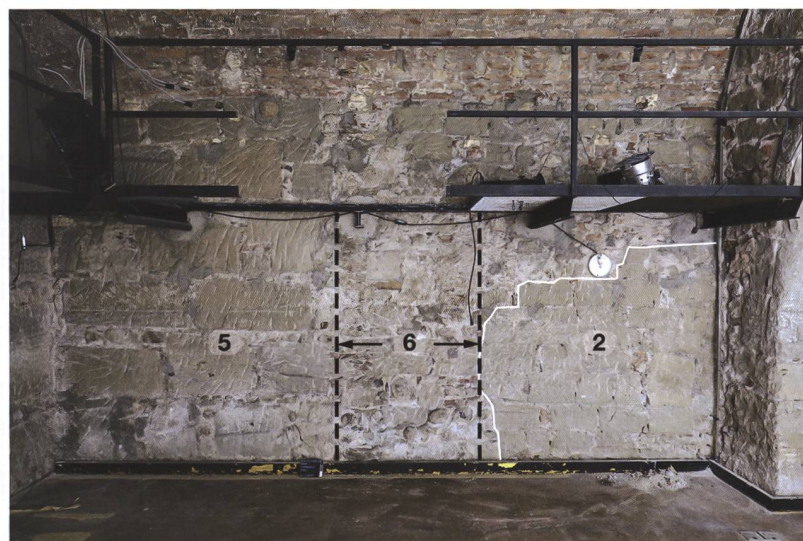
4 Bern, Kramgasse 4. Ostwand. Mauer (2) und der Wandverband der abgebrochenen Mauer (6) der Bauphase 1; Mauer (5) der Bauphase 3. Darüber das Backsteintonnengewölbe.
