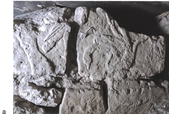
50 Saint-Denis/Paris, Fulrad-Basilika. Säulenbasis, in situ unter dem heutigen Bau. Süd- (a) und Ostseite (b) der westlichsten heute sichtbaren Basis.
