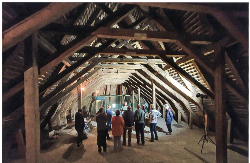
15 Les nouvelles analyses dendrochronologiques ont démontré que les bois de la charpente située au-dessus du chœur de l'église française de Berne ont été abattus en 1279.
