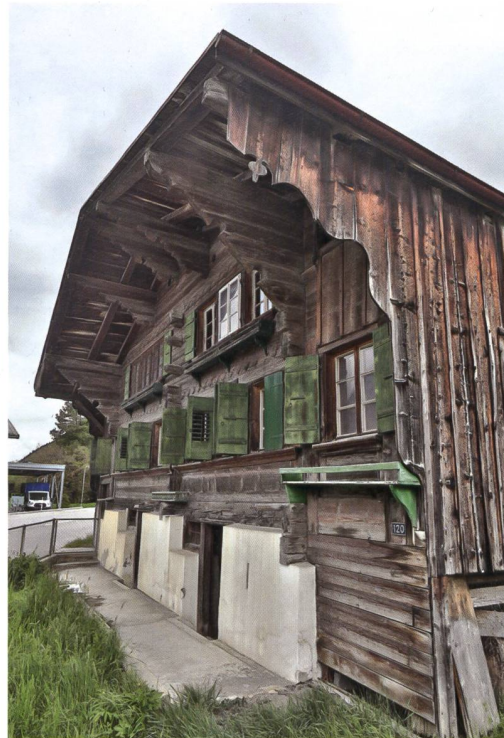
14 Der Ständerblockbau in Saanen an der Dorfstrasse 120 konnte vor dem Abbruch dokumentiert und dendrochronologisch ins Jahr 1671 datiert werden.
