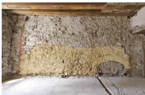
3 Biel, General-Dufour-Strasse 22. Erdgeschoss des Schulhauses. Rot: Negativ der Stadtmauer, 14. Jahrhundert; gelb: Mauer 4 der Johanniterkommende, 15. Jahrhundert. Blick nach Südwesten.
