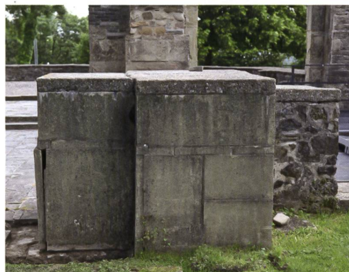
7 Rüeggisberg, Kloster. Südwestlicher Vierungspfeiler der Klosterkirche mit der Plattenverkleidung der 1980er-Jahre. Blick nach Osten. Aufnahme von 2016.
