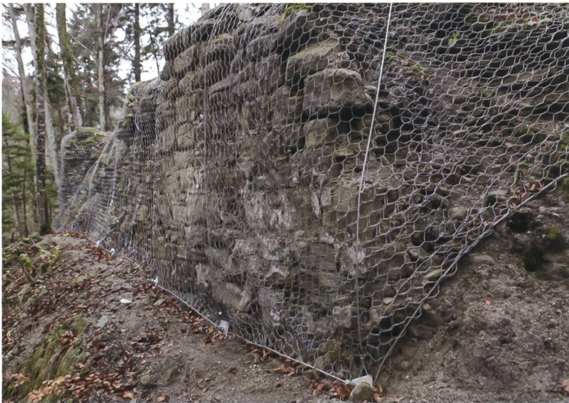
12 Köniz, Riedburg. Als präventive Massnahme wurde die freiliegende Mauer zur Stabilisierung und wegen Steinschlaggefahr durch ein Stahlnetz gesichert. Blick nach Nordwesten. Aufnahme von 2019.
