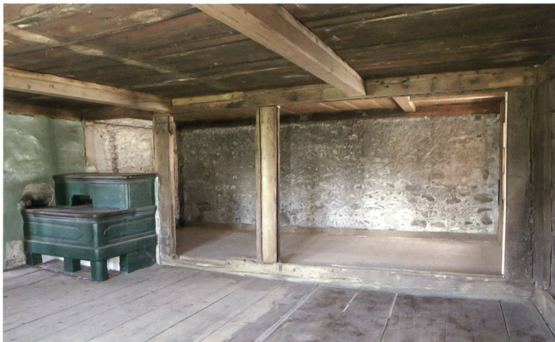
20 Thun, Schorenstrasse 40. Blick nach Nordwesten in den Raum 30. Vom Vorgängerbau verblieb die Mauer (16) (hinten) und ein Rest der ehemaligen Binnenwand (55) zur Rauchküche (hinten links). In Phase 3 errichtete man zwei Ständerbohlenstuben. Zustand 2020.
