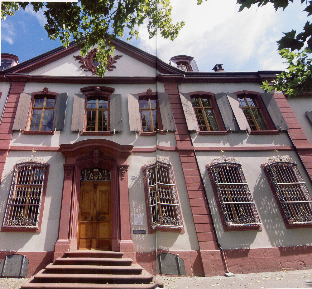
Der Holsteinerhof an der heutigen Hebelstrasse
