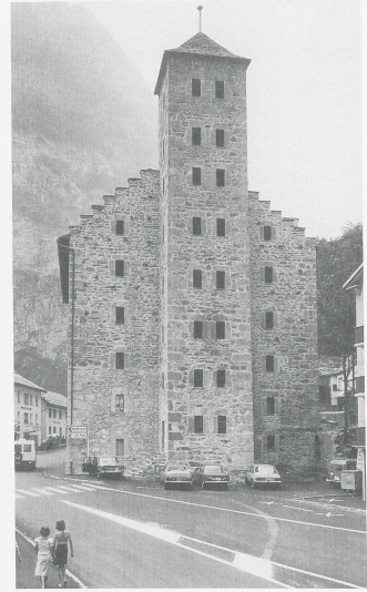
Stockalpers Suste in Gondo, erbaut 1670. Der mächtige fünfgeschossige Bau mit dem im Osten vorgelagerte Frontturm diente als Herberge und als Lagergebäude für den Warentransport über den Simplon.
