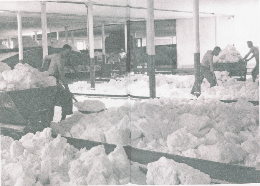
Das Salz wurde nach dem Abtropfen von den Siedepfannen in Trocknungsräume gebracht, dort mit Abwärme von den Heizöfen getrocknet und dann in die Salzmagazine gekarrt. Aufnahme um 1905.
