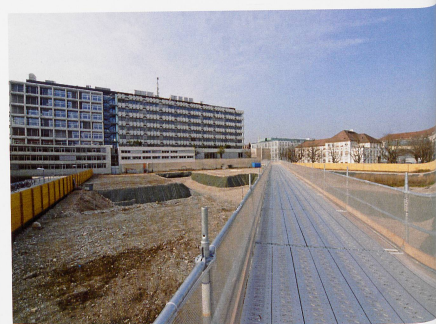
Schällemätteli damals (oben) und Baugrube heute.
