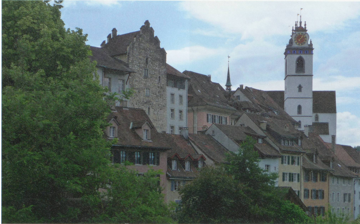
Bild links Blick auf die Altstadt von Aarau
