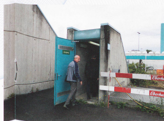
◀ Der Zugang zum Abwasser
