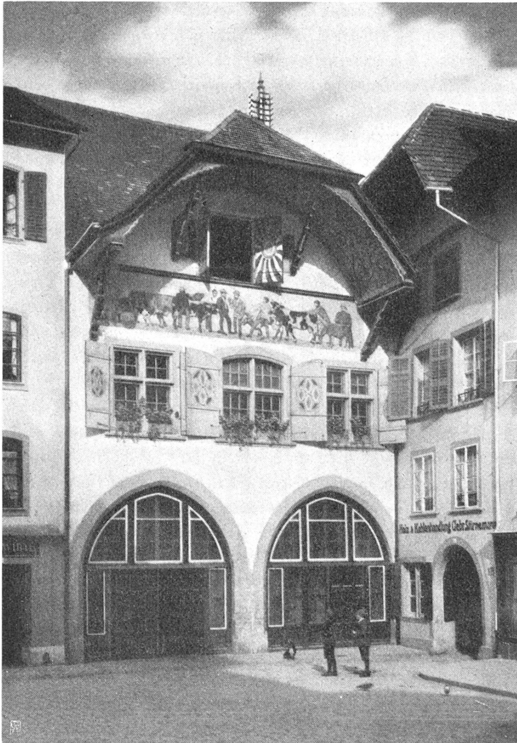
Die alte Schal (Schlachthaus mit Tuchlaube)
