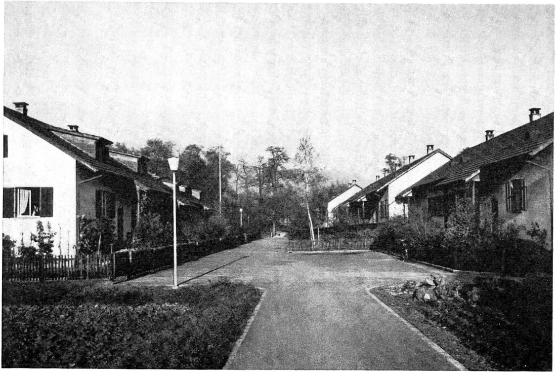
Wohnbaugenossenschaft Aarau 1942, Scheibischaden
