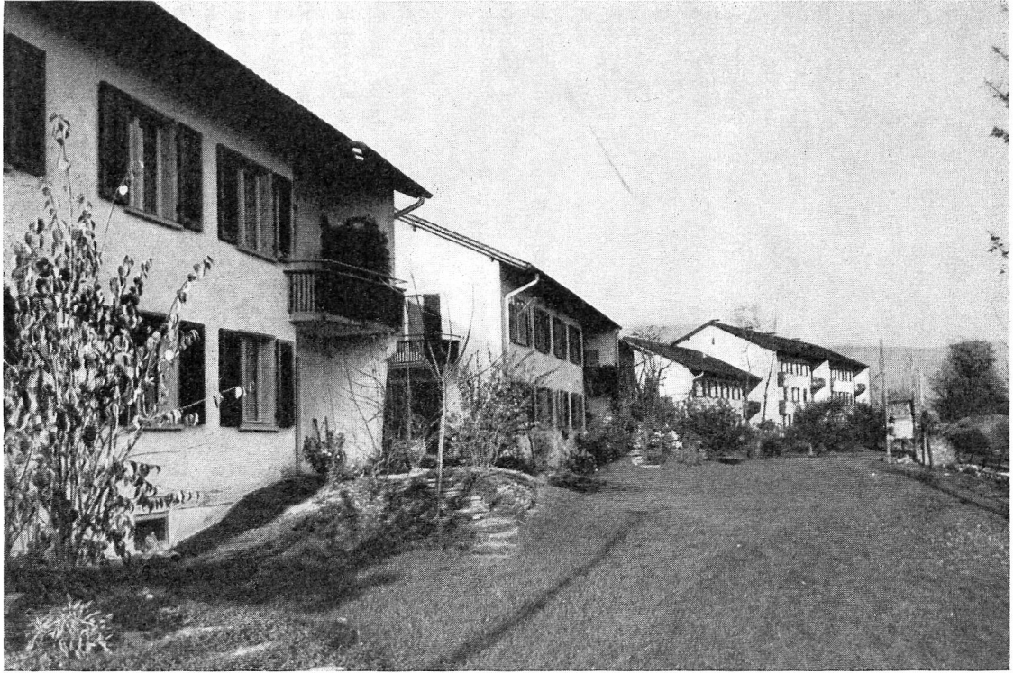
Allgemeine Wohnbaugenossenschaft Aarau und Umgebung, ABAU, Telli
