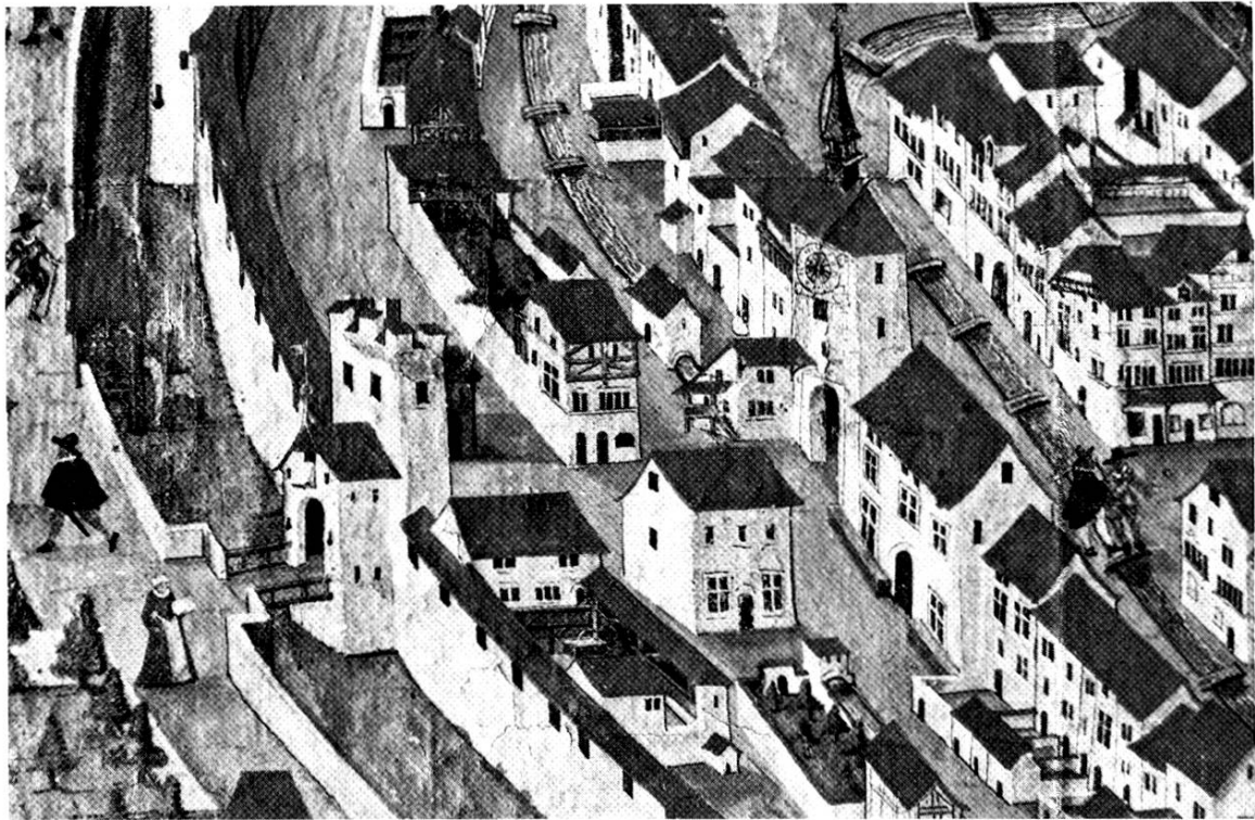
Abb. 17 Aarau von Norden, Ölbild von Hans Ulrich I Fisch, 1612. Ausschnitt der Laurentztoranlage. Die durch den Bau des zweiten Tors entstandene Doppeltoranlage unterstreicht mit zwei Türmen die Bedeutung dieses Stadteingangs. Das äussere Tor ist durch das wohl erst um 1480 angebaute Vorwerk in den Graben hinaus erweitert. Aarau, Rathaus.
