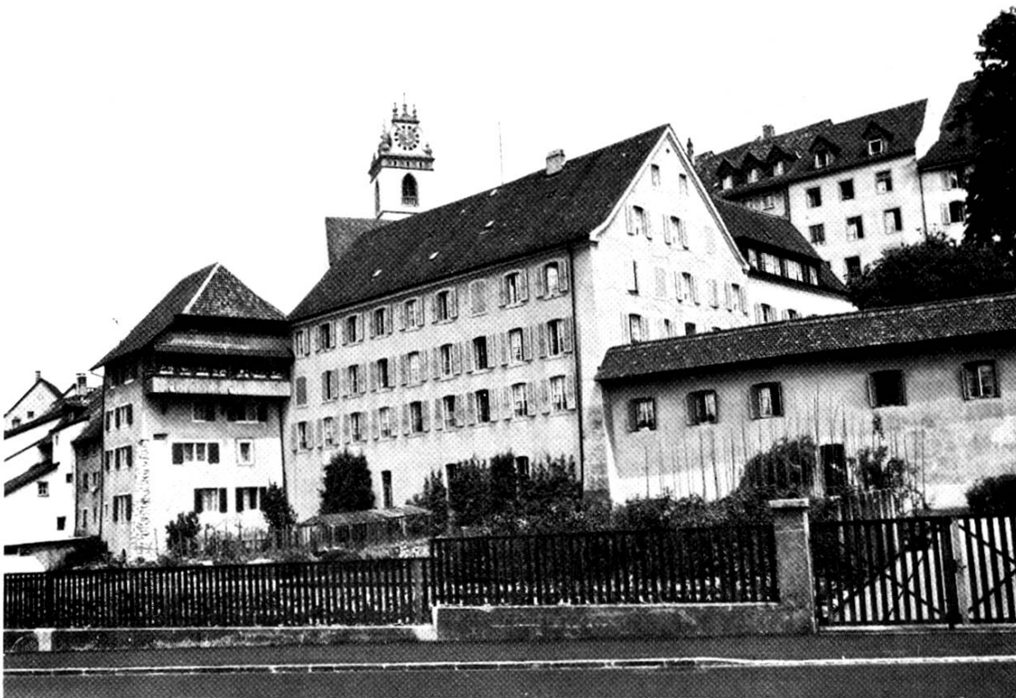
Abb. 35 Als Gartenmauer erhaltenes Teilstück der Ummauerung des Klosters beim Altersheim. Links Haus Halde Nr. 64, Südostecke der Haldenmauer.
