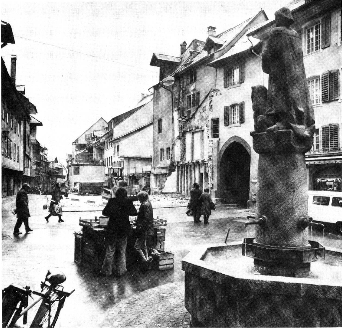
Neue Perspektiven durch die Baulücke zwischen den Toren.
