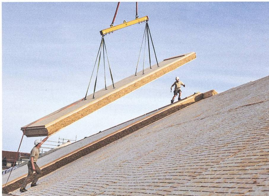
→ Montage der zwölf Meter langen Überdach-Elemente.
