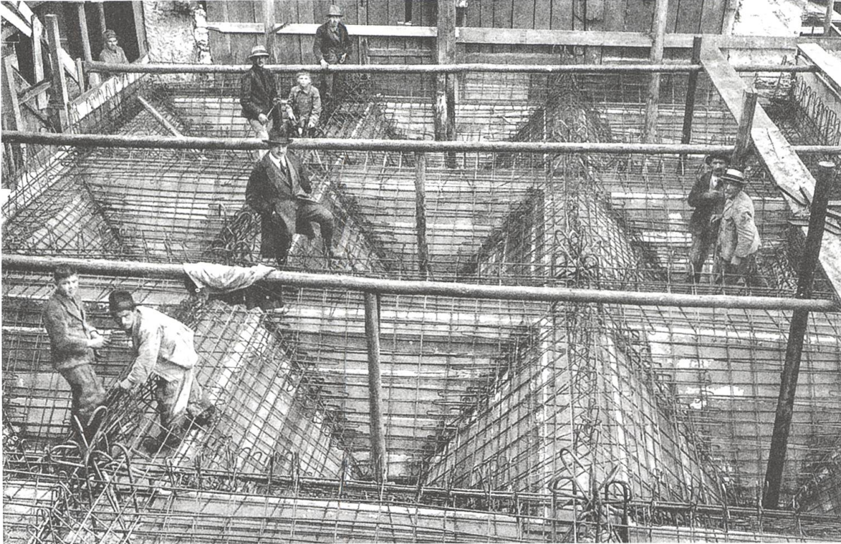
↑ Bau der Silotrichter für die Stadtmühle Aarau. Rechts mit heller Jacke, Luigi senior, in der Mitte mit Mantel, Angelo De Maddalena. (Werbe-album De Maddalena & Söhne)
