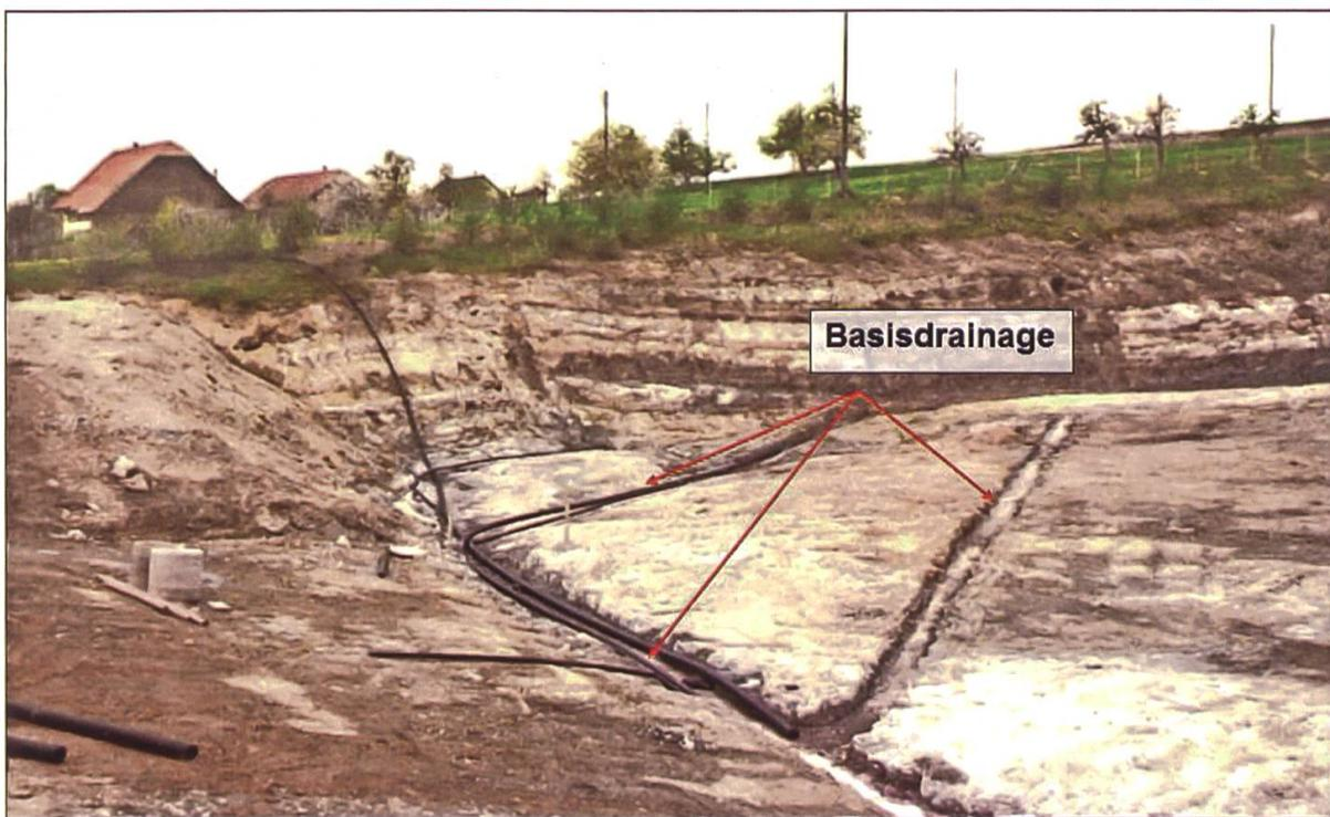
**Abb. 4:** Leere Grube 1977, vor Einbringen des Sondermülls. Anstehender Molassefels, rudimentäre Basisdrainage, keine Basisabdichtung, vergl. auch Abb. 3
