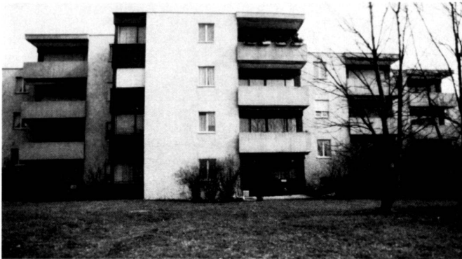
Abb. 6: Bei den meisten Sitzplätzen beschränkt sich die Ausstattung auf einige Quadratmeter Plattenbelag. Fig. 6: A la plupart des places pour s'asseoir, l'équipement se limite à quelques mètres carrés de dallage. Fig. 6: Most of the seating patios consist of just a few square meters of paving stones.
