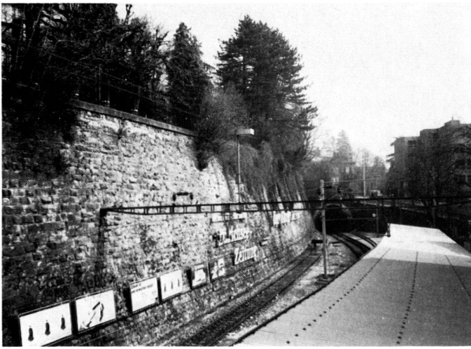
Links: Alte vorhandene Natursteinmauer. Bereich Falkenburg, Hohenbühl mit Tunnel Westportal.
