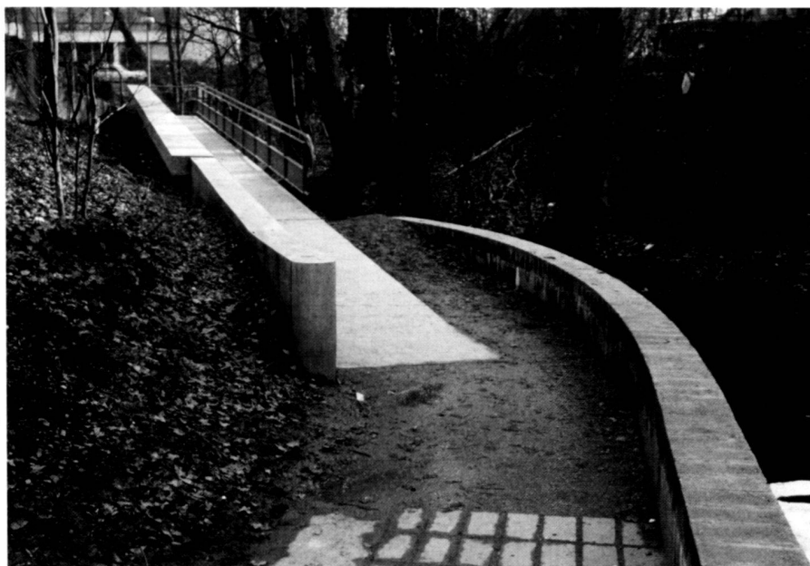
Fussgängerpassage – Steg zum Tunnel.
