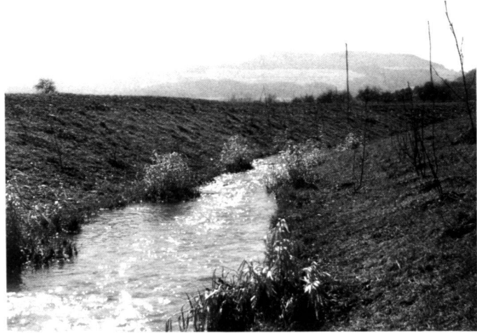
A gauche: Protection des rives assurée par une combinaison de fascines.
