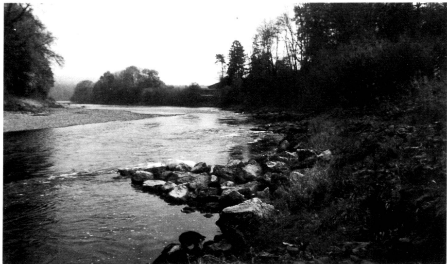
A gauche: Le tronçon aval avec ses épis après une période de végétation.
