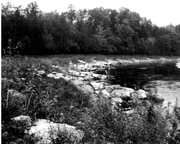
Links: Die Bühnenstrecke flussabwärts nach einer Vegetationsperiode.
