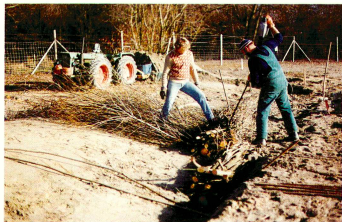
Faschinenbau, Austrieb im ersten Jahr.
