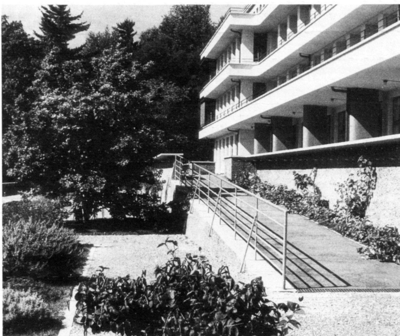
Links: Die neue Rampenanlage des Lory-Spitals.
