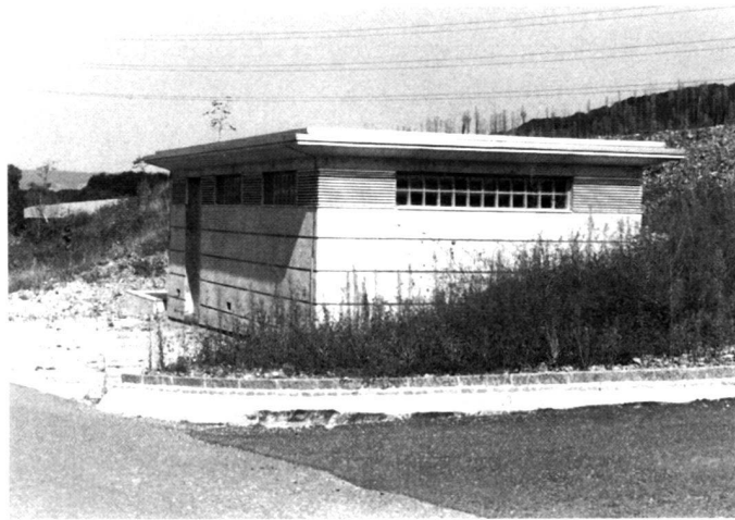
Unterverteilstation, Werkgebäude für Elektroverteilung und Verkehrssteuerung. Substructure de distribution électrique et de réglage de la circulation. Infrastructure building housing the power distribution and traffic control equipment.
