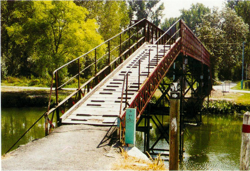
Kleine Stahlbrücke, Architekturtradition der Region.
