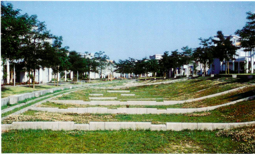
Grüne Mitte in der Küppersbusch-Siedlung in Gelsenkirchen: Platzlinse zur Regenwasserrückhaltung. Landschaftsarchitekten Büro Brandenfels.
