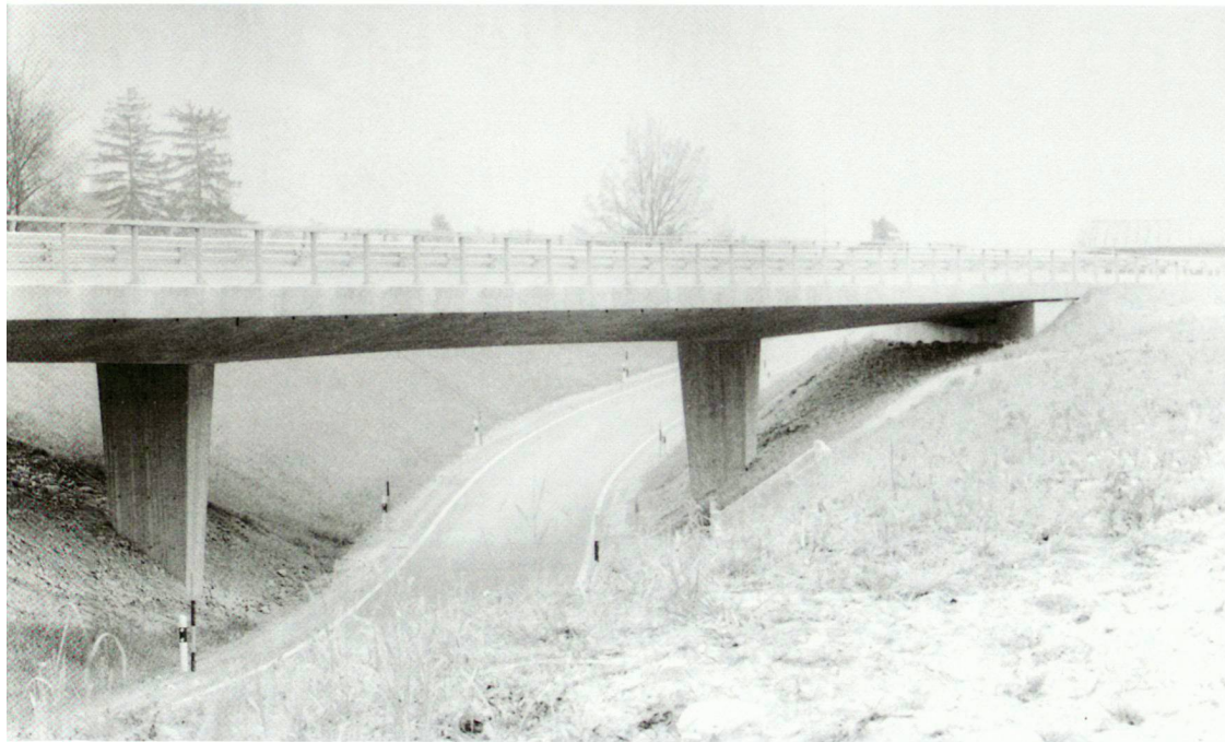
Überführung Landquartlösser, 1994, vorgespannte Betonbrücke
