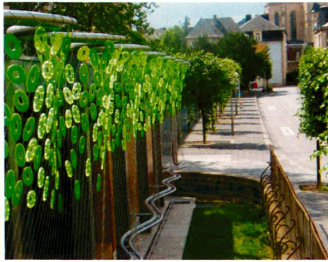
IOC/IAKS AWARD 2007 – Gold Sporthalle Schule Dellheicht in Esch-sur-Alzette (Luxemburg) Architekt: Witry & Witry, Echternach
