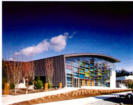
IPC/IAKS SONDERPREIS 2007 West Vancouver Aquatic Centre (Kanada) Architekt: Hughes Condon Marler, Vancouver
