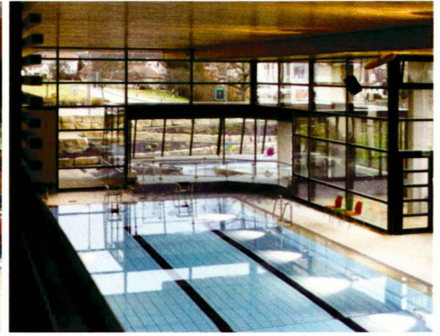
IPC/IAKS SONDERPREIS 2007 Erich-Fischer-Halle in Aldingen (Deutschland) Architekt: Dipl.-Ing. Uwe Bertsche, Aldingen
