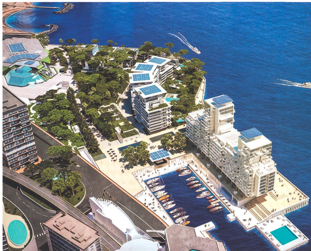
© Valode & Pistré Architectes
