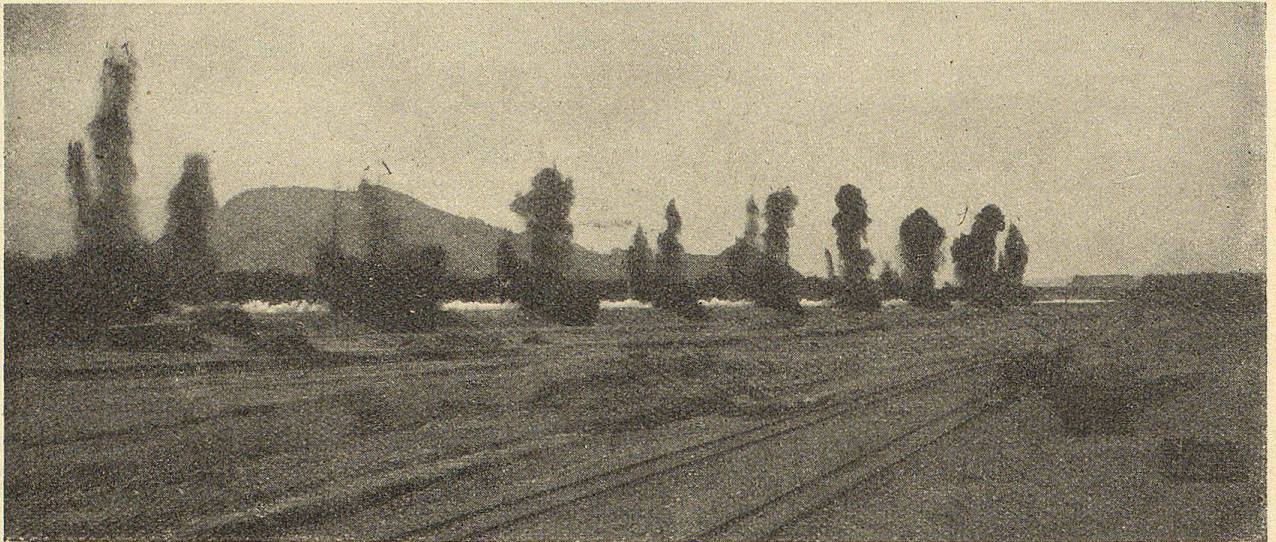
Fig. 7. Sprengung zur Beseitigung der letzten Scheidewand zwischen dem alten und neuen Rheinbett. Das Bild zeigt die gleichzeitige Entzündung von 29 Minen. Man beachte die Querkwirkung der Explosions, durch welche der Damm der Quere nach aufgerissen wird.
