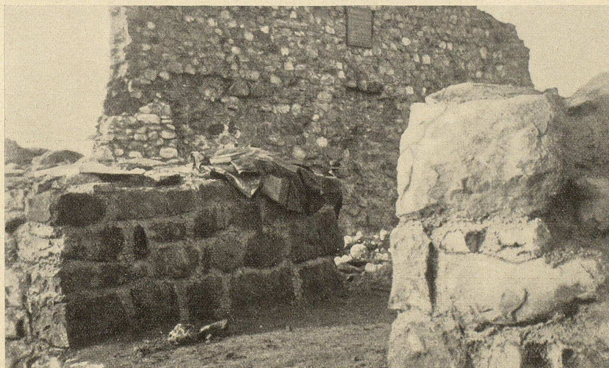
Innenansicht aus Südosten nach der Westmauer. Aus der Höhenlage der Inschriftstafel über dem Boden vor (Bild oben) und nach Beendigung der Ausgrabung (Bild unten) erkennt man, wie tief die Mauer im Schutte steckte. (Im Vordergrund das Tor in der 2,35 m breiten Südmauer.) — Phot. S. Fäßler, Helfenberg, Gofau (oben); J. U. Meng, Herisau (unten).
