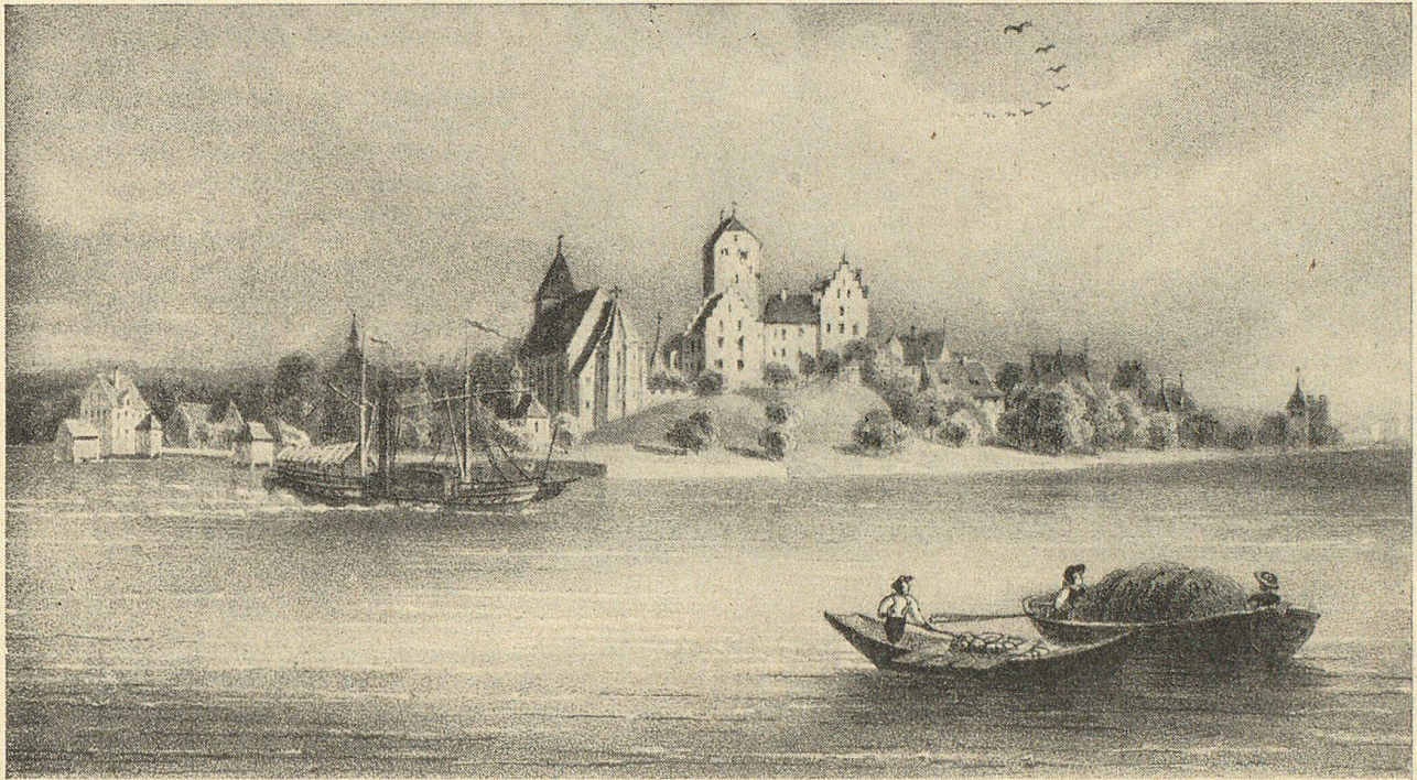
Ansicht von Arbon von der Seeseite. Nach einem alten Stich
