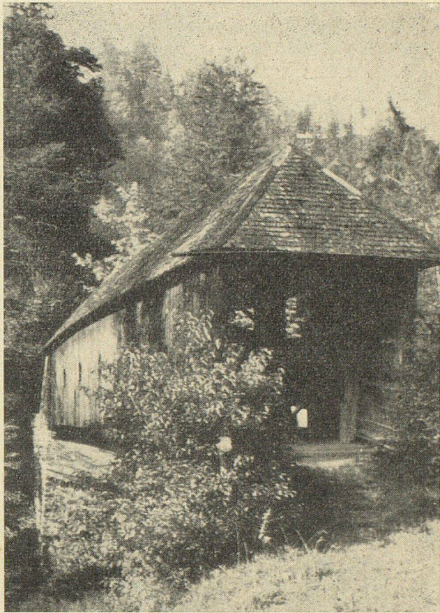
Die Brücke im Rachtobel
