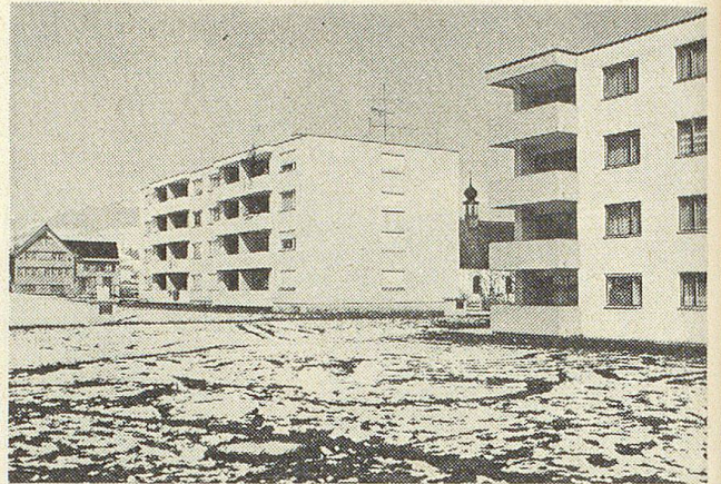
Fantasielose Flachdachbrocken erdrücken die reizvollste Barockkapelle Innerrhodens, St. Anton im Rinckenbach. (Folge elastischer Baugesetzgebung?)
