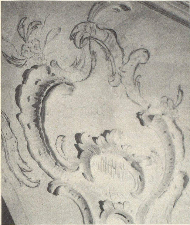
Mit Bleistift aufgezeichnete Rocaillen, die der Stukkateur möglichst getreu nachbildet
