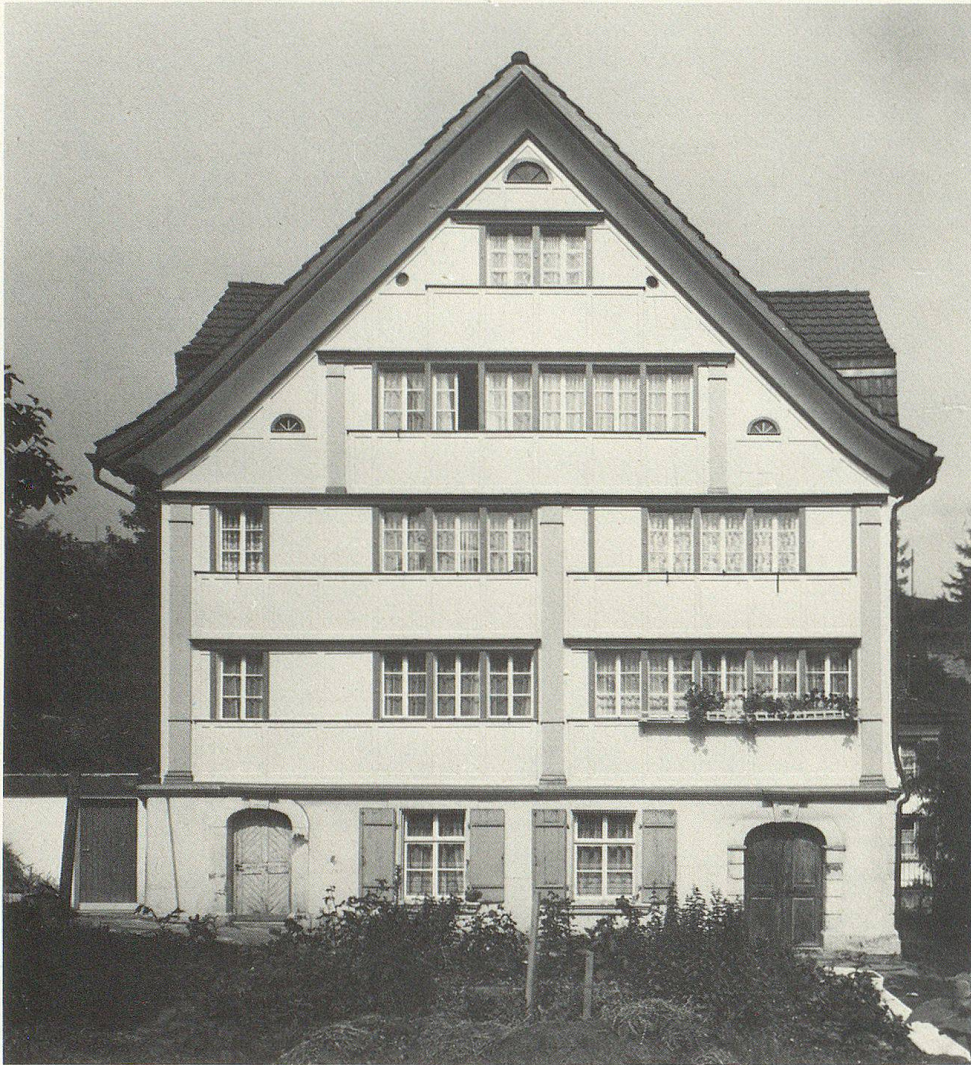
Fabrikantenhaus von 1785 im Hinterdorf, Speicher, mit Fronttäfer von 1844. Das Bürgerhaus des 18. Jahrhunderts bekennt sich mit Reihenfenstern und Giebdach zur einheimischen Bautradition. Vom gewöhnlichen Bauernhaus mit Webkeller unterscheidet es sich besonders durch das Erdgeschoss und seine schönen Portale. Die seitlichen Mansardgiebel verraten den im letzten Viertel des 18. Jahrhunderts wirksamen Einfluss des Barocks.
