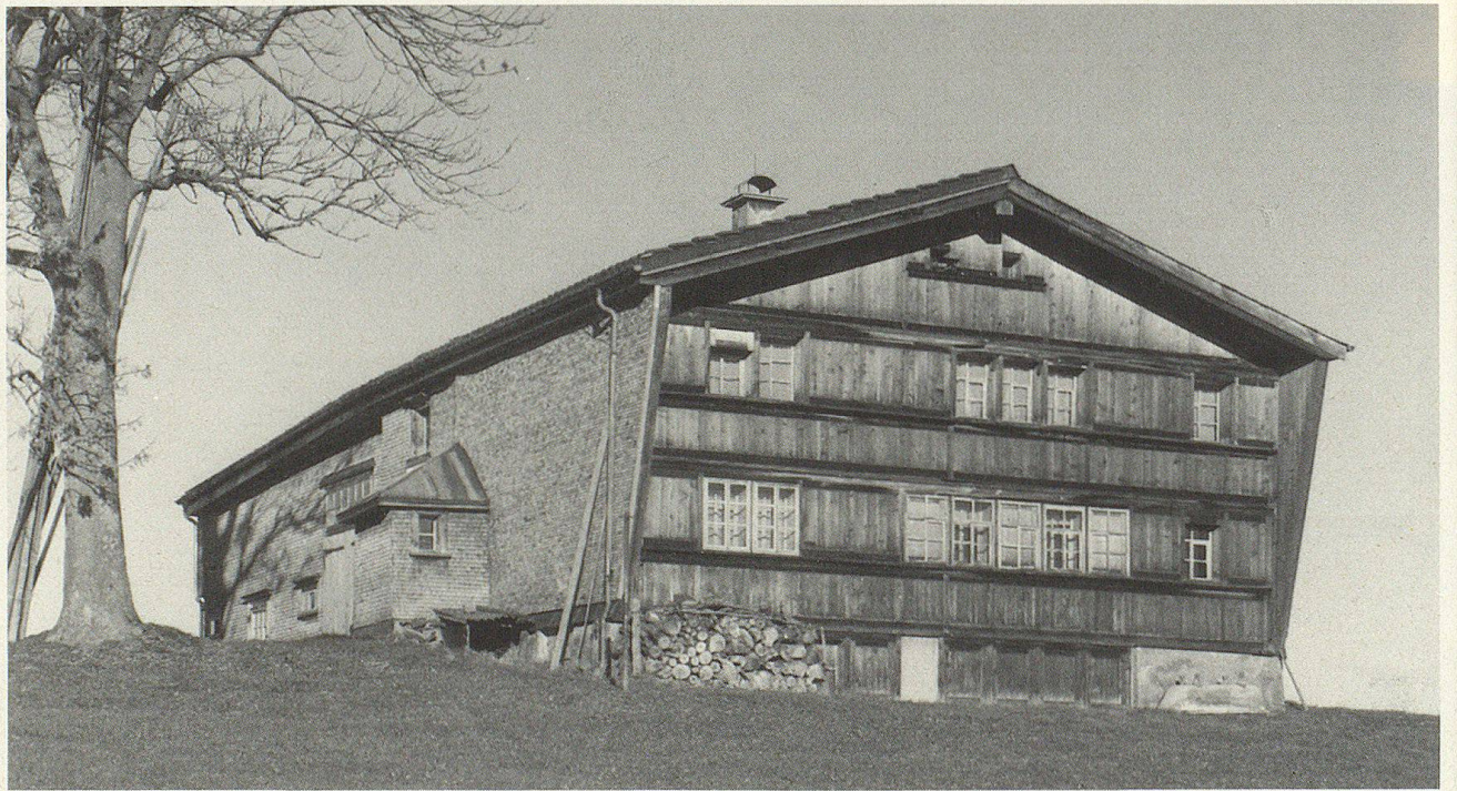
Oben: Sogenanntes Heidenhaus, ein Haus mit Tätschdach in Traufstellung. Es gilt mit guten Gründen als der älteste Haustyp. (Die Stallscheune [«Stadel»] mit steilerem Satteldach wurde später angefügt.) Bauernhaus im Ratholz («Rodholz»), Trogen.
