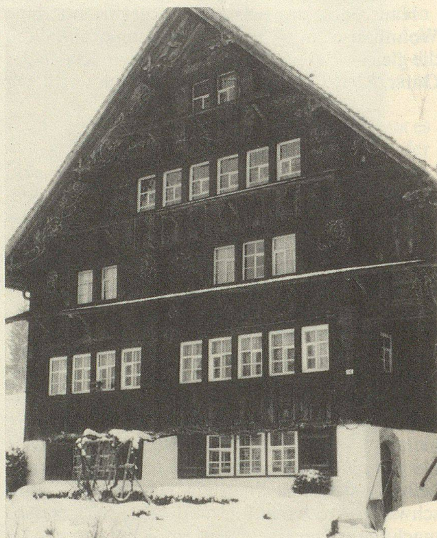
Das Haus der Albert-Edelmann-Stiftung, 1752 erbaut, 1952 von Oberhelfenschwil nach Ebnat-Kappel versetzt.
