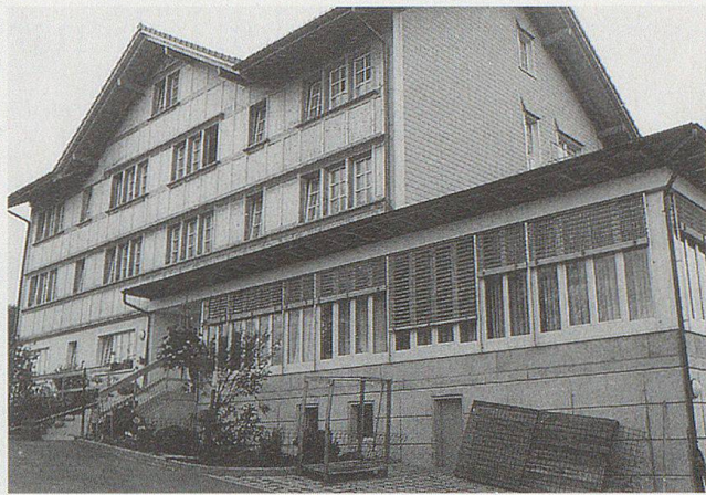
Am 14. April 1994 wurde das Altersheim Torfnest ein Raub der Flammen. Ein Pensionär und eine Pensionärin verloren dabei das Leben. 1996 konnte der Neubau bezogen werden.
