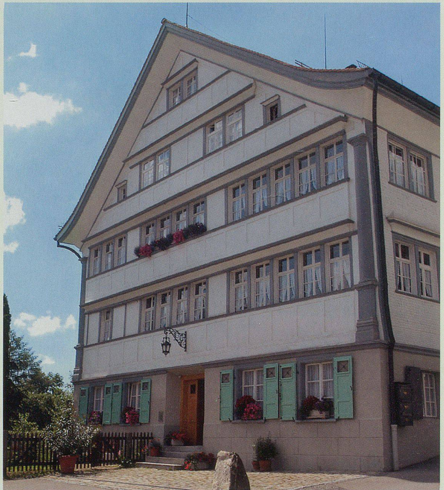
Das Gemeindehaus der Gemeinde Bühler.
