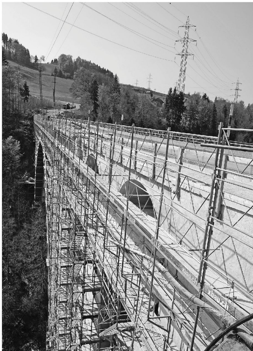
Sanierung im Jahre 2011.
