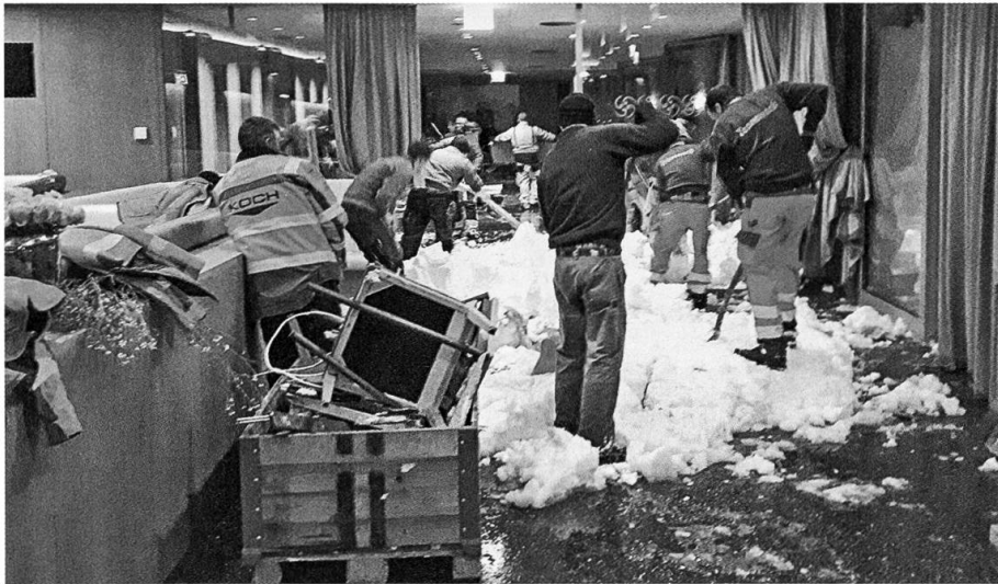
Auf die Schwägalp gehen zwei Lawinen nieder. Die Schneemassen dringen bis ins Hotel Schwägalp vor und beschädigen eine Stütze der Schwebbahn.
